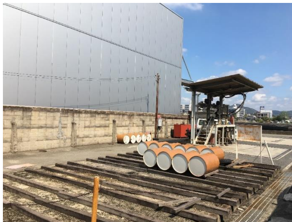
A 重油 10 タンク 10KL×2本 LSA タンク 30KL×1本
