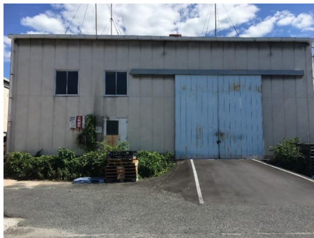
1号棟 150m 2 (危険物第4類)
